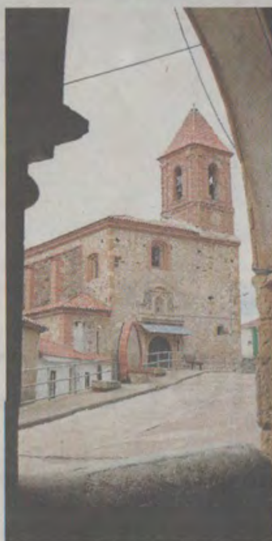
Del interior del trinquete se ve la iglesia
